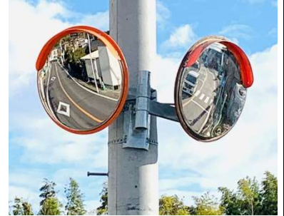
【修繕の例(東方 993) 歪んだミラーの取り換え】 (大型車両等が接触しないよう位置を上に移動)
