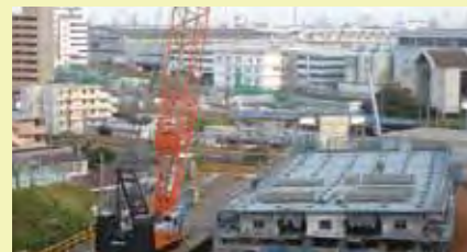
子安台地区の現場から生麦方向を望む
